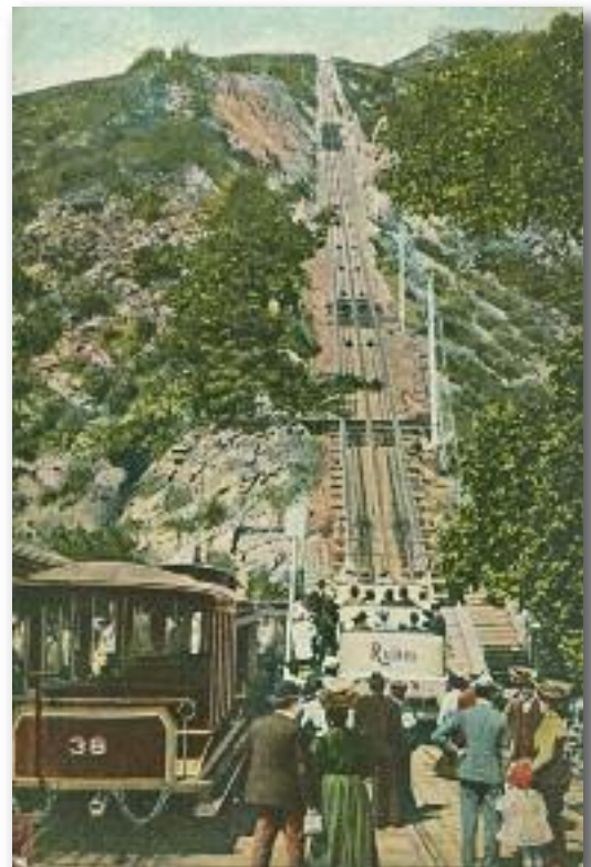
Mt. Lowe Incline
